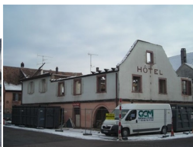
... au démarrage des travaux
